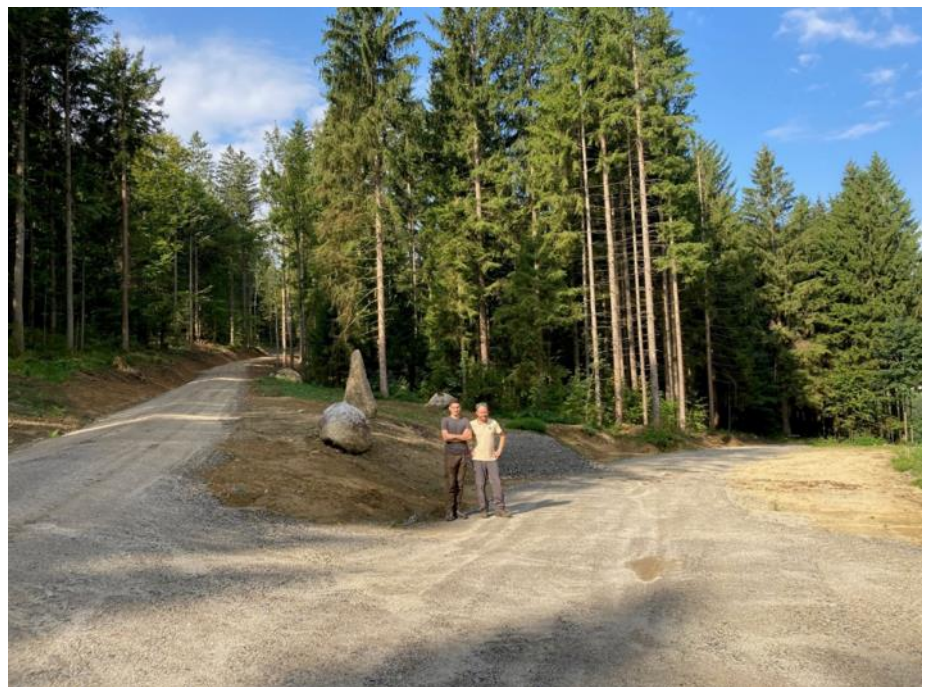
Forststraße Lamprechtswiesen in Oberkappel, Fertigstellung September 2023, Projektierung und Bauaufsicht durch den Forsttechnischen Dienst der BH Rohrbach. (links: Forstadjunkt Stefan Schachl-Lughofer, rechts: Bezirksförster Ing. Sebastian Köppl) Quelle: Land OÖ
